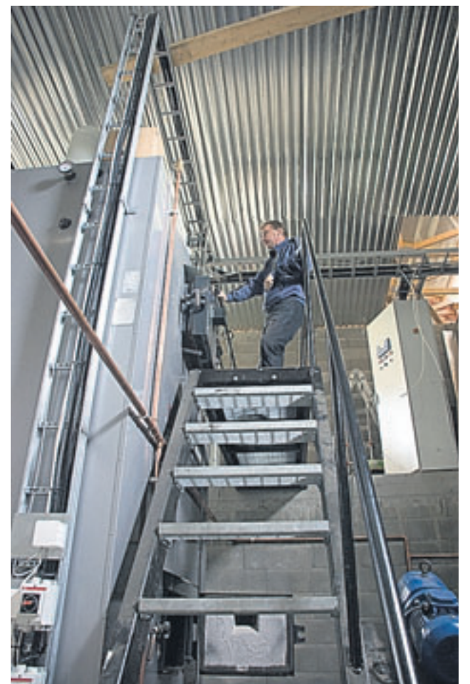
Kuva pystyruuvien vierestä alhaalta. Hieman ahdas rinnettöinti ei ole paras mahdollinen lämpölaitokselle, kun tarvitaan ylimääräinen ruuvikin.
