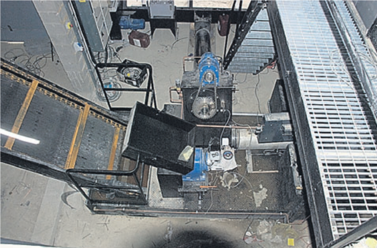
Kuva toisesta suunnasta ylhäältä. Nyt hakevarasto on kuvassa ylhäällä. Varastonruuvi näkyy vaalean, varaston lattian, alapuolella. Pystyruuvilla hake nostetaan pudotussuppiloon, josta hake siirretään yhdellä ruuvilla kattilaan. Kuvassa vasemmalla on ketjukolakuuljetin märälle tuhkalta. Kattilahuoneessa on tilaa tehdä huoltoja.
