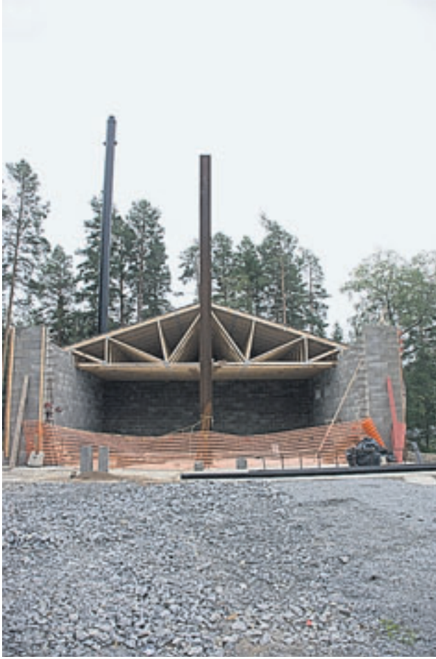
Laitos on periaatteessa toimintavalmiina, vaikka hakevarasto ei ole vielä katettu. Katon se lienee jo saanut päälensä.
